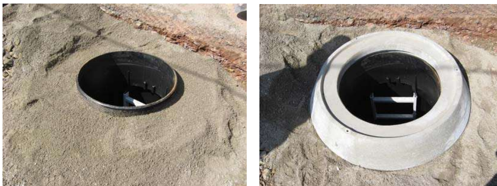
Slika 9 i 10: Postavljanje betonskog prstena za prihvatanje opterećenja
