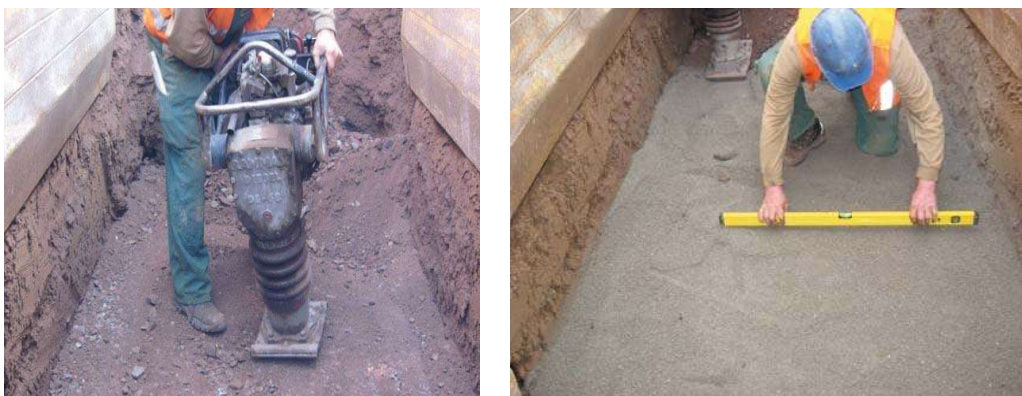
Slika 1 i 2: Priprema podloge za polaganje šahtova
