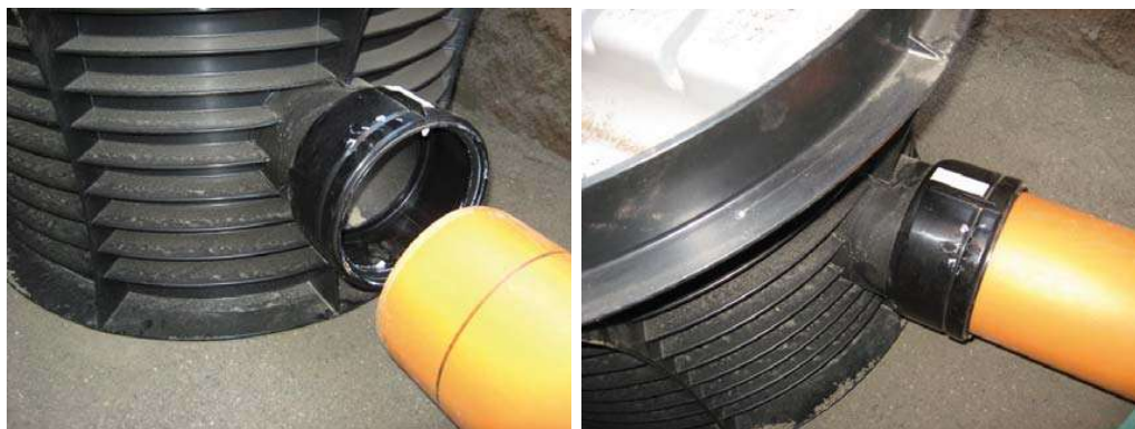
Slika 5 i 6: Izvođenje spoja šahta sa PVC cijevima
