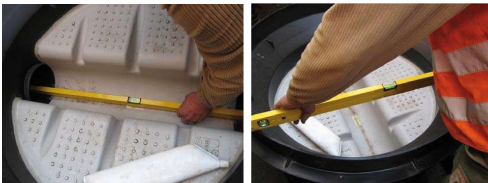
Slika 3 i 4: Kontrola položaja odvoda
